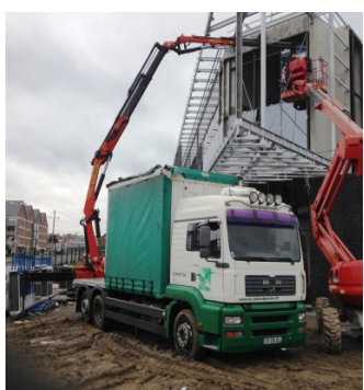
Pose en accès difficile:
