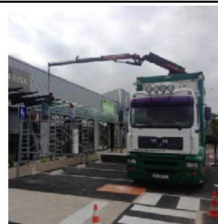
Pose sur verrière:
