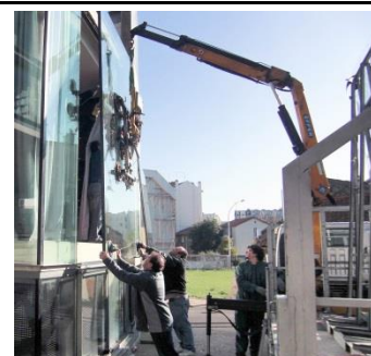
Pose sur mur-rideau:
